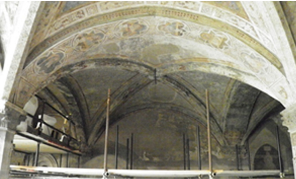
Situation Restaurierung der Rundbögen
