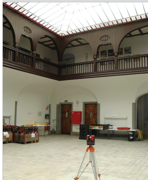
Der Leica 3D Disto erfasste exakt die Formen der Elemente der Glaskuppel vom Boden aus.
